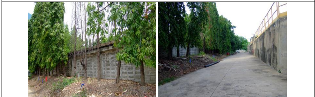
รูปที่ ๗.9 รั้วคอนกรีตสูง 3 เมตร ล้อมรอบโครงการ
